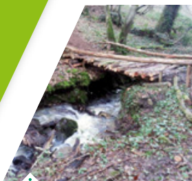
Fabrication d'un pont sur un terrain privé à Cardroc
